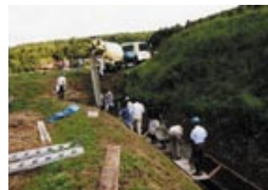
集落で行われる用水路の補修作業
