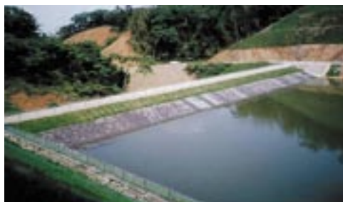
成丈ため池（松江市鹿島町）
