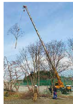
吊り伐りによる支障木の特殊伐採作業
