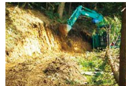
作業道開設作業
