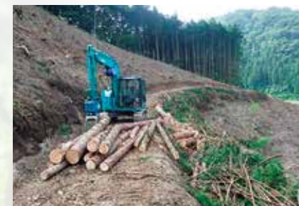
伐採木搬出作業
