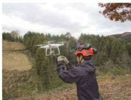
■UAV を活用したリードロープ運搬
